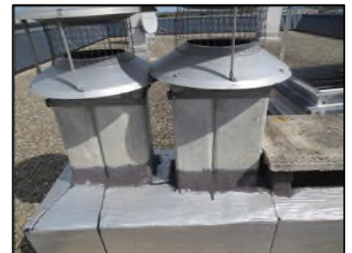
Photo N° 646 AMIANTE CIMENT -- Toiture terrasse Toiture Ventilation haute (Fibres-ciment)
